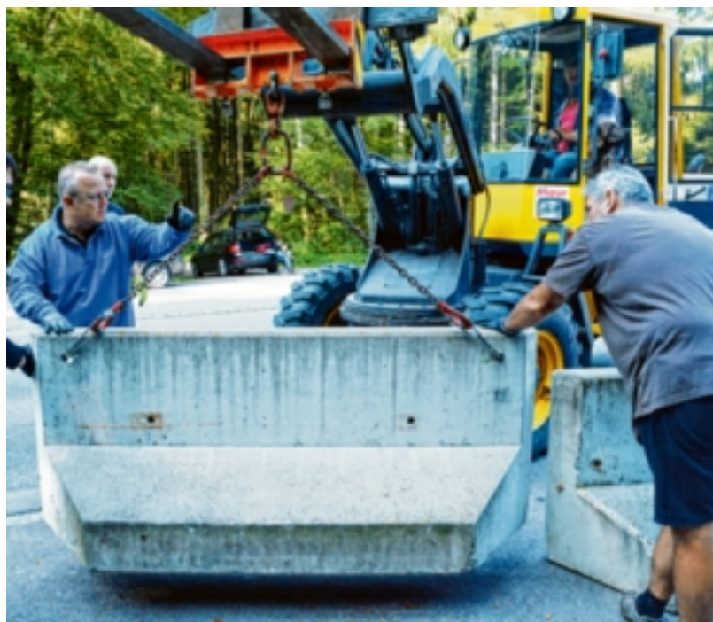
Schwere Betonteile sind nötig, um die Zuschauer und die Rennfahrzeuge voneinander zu trennen und voneinander zu schützen.
